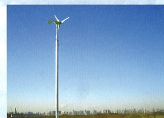
東京都・お台場埋立地 (東京大学お台場風力実験場)
